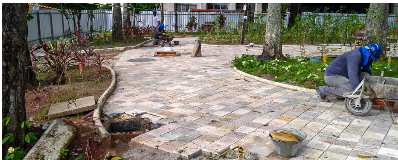
Pedras do passeio e da calçada foram substituídas no projeto atual
