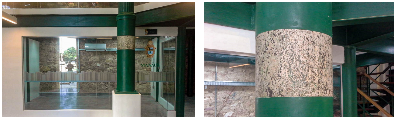
Janela de testemunho do pilar de ferro expõe o revestimento original em escaiola, uma técnica comumente aplicada sobre alvenarias
