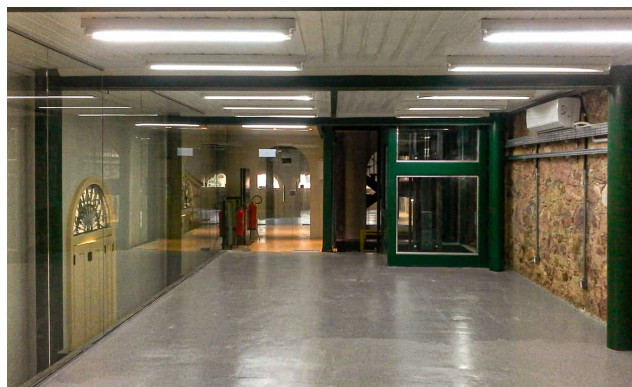
Salas que abrigarão o acervo e o processamento tiveram o reboco removido para dar destaque às pedras jacaré
