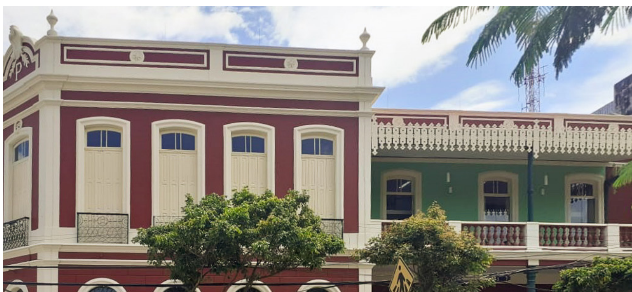
Adorno recortado no beiral da varanda superior foi replicado seguindo o projeto original
