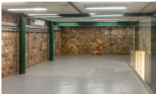
Salas que abrigarão o acervo e o processamento tiveram o reboco removido para dar destaque às pedras jacaré
