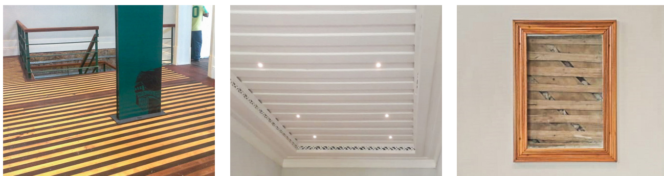
O assoalho restaurado, o forro do teto e a parede de taipa são os grandes destaques do hall de acesso
