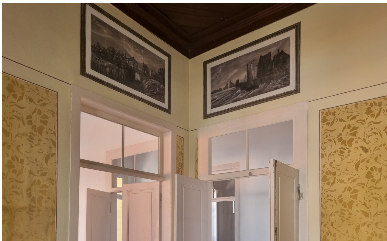
A técnica consistiu na utilização de moldes em folhas de acetato que servem de guias para pintura
