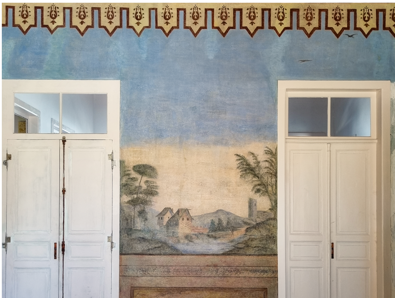
O restauro visa à conservação de elementos preservados e à restauração de ornatos danificados
