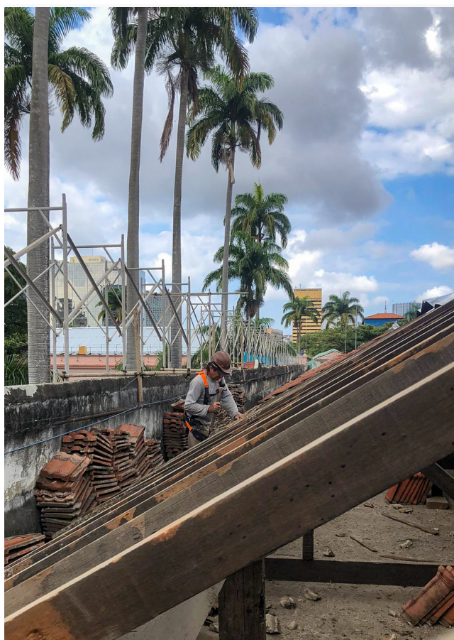
Telhado foi completamente restaurado e recebeu tratamento especial contra cupins
