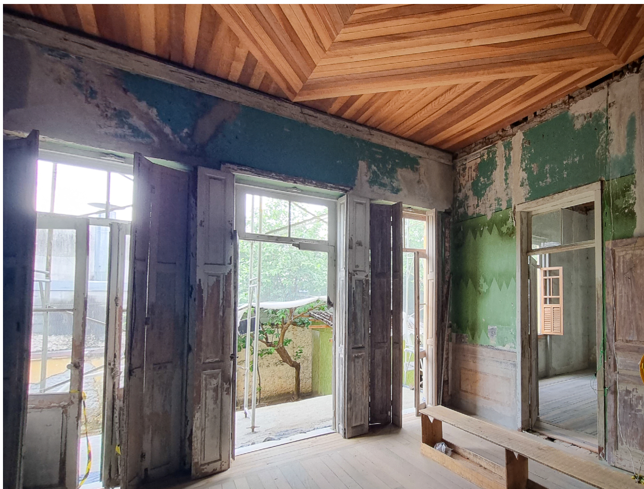
Localizada na região da praça Santa Teresinha, a residência foi tombada pelo município em 1985
