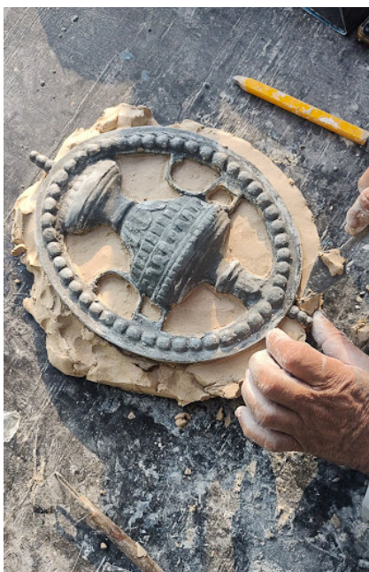
Restauro de ornamentos e frisos da edificação estão sendo refeitos a partir de moldes originais
