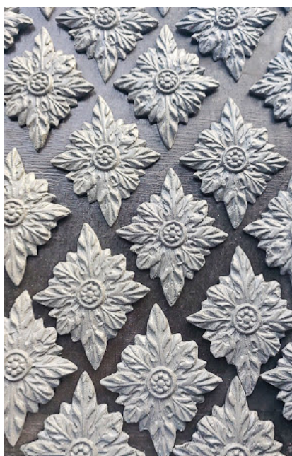
Restauro de ornamentos e frisos da edificação estão sendo refeitos a partir de moldes originais
