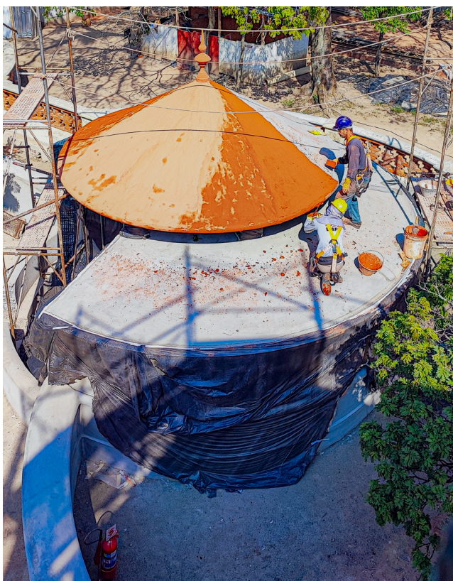
Técnicas de prospecção indicaram o revestimento original do antigo biotério
