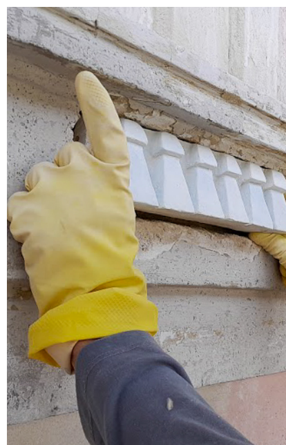
Restauro de ornamentos e frisos da edificação estão sendo refeitos a partir de moldes originais
