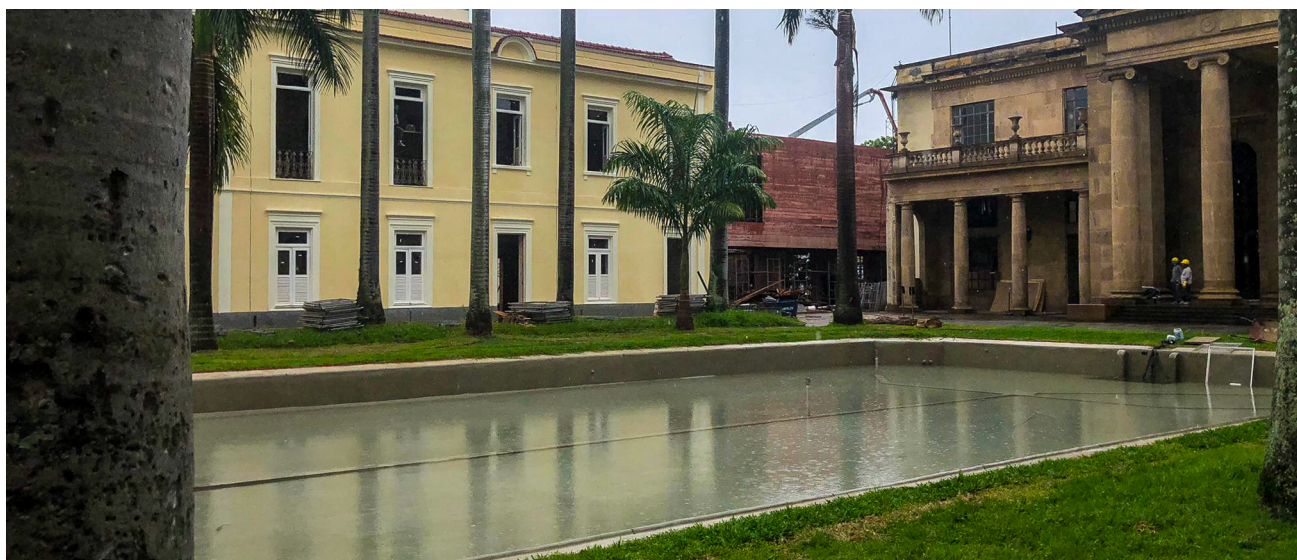
Reparos incluíram a recomposição de todo o contrapiso
