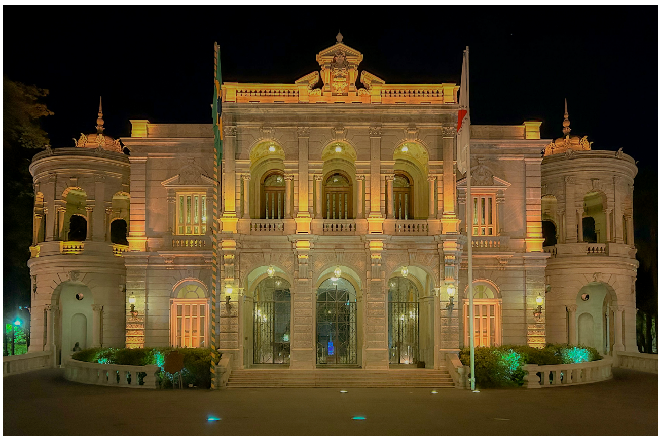
Iluminação cênica da fachada principal está em fase de finalização/Crédito foto: Matias Restaurações
