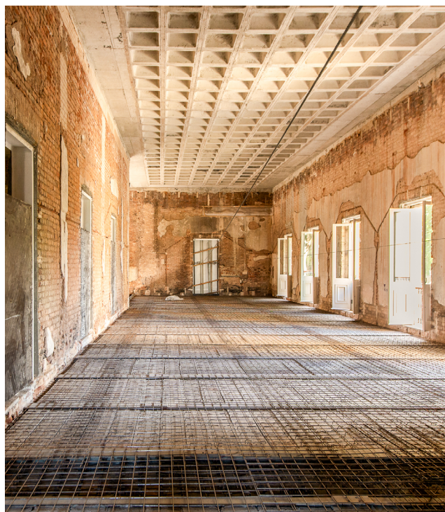
Execução de lajes intermediárias no bloco 1, com estrutura composta por vigas metálicas, painéis treliçados e laje maciça.
