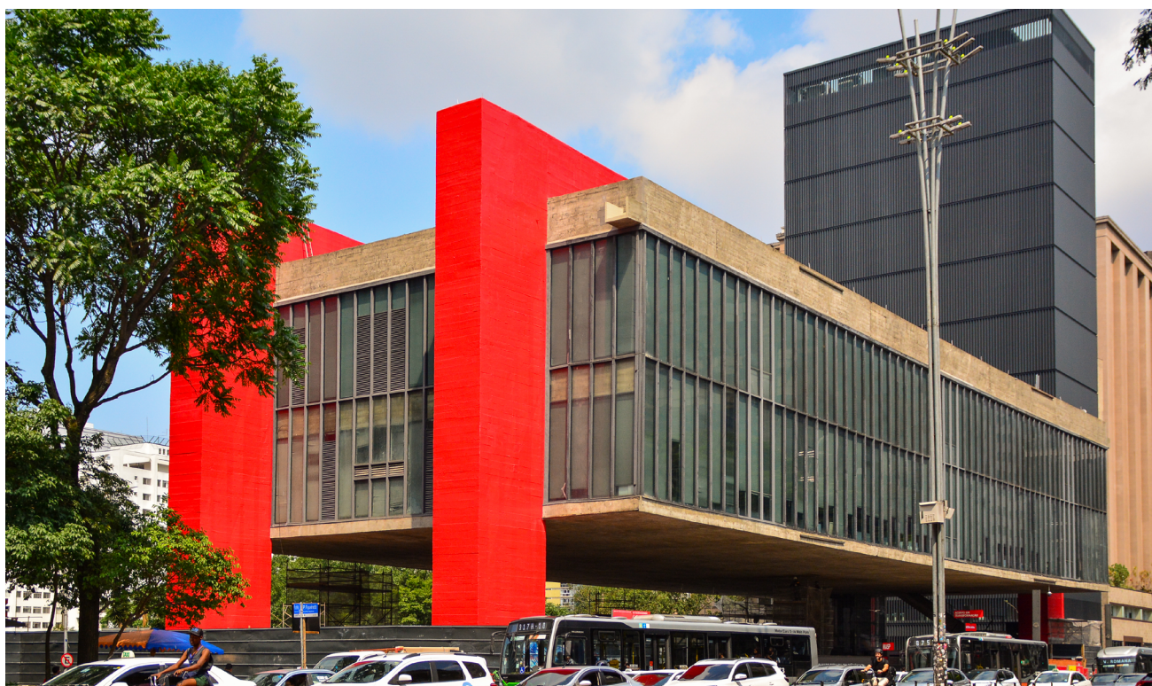
Elemento de destaque na obra de Lina Bo Bardi, a pintura vermelha dos pórticos do MASP está finalizada/Crédito foto: Marco Scriboni
