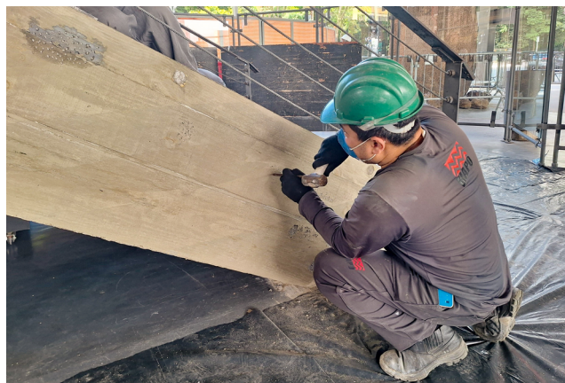
Serviços de restauro da laje e da escada da entrada principal foram realizados seguindo as características do projeto original
